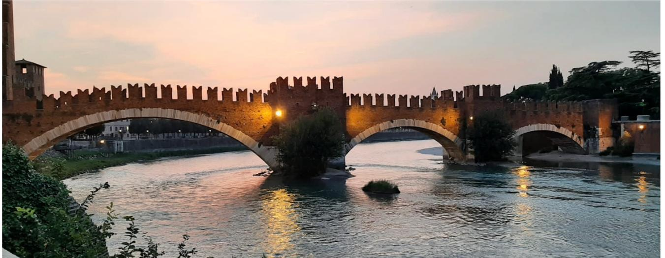
Abb. 3: Mögliche Brückenkonstruktion - Scaligero-Brücke ist eine typische Bogenbrücke, deren Brückenpfeiler als Wehrtürme fungieren
